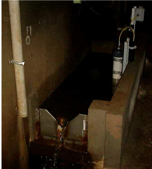
Foto 7– Medidor de Vazão de Placa Triangular
