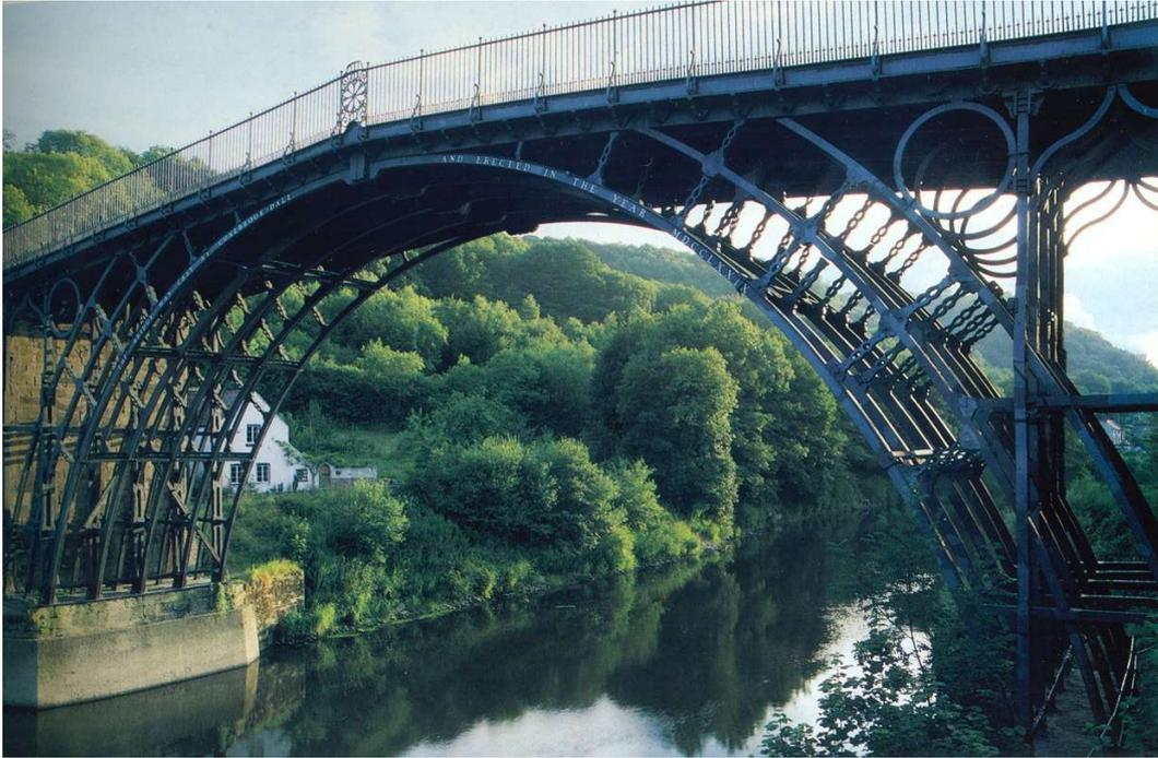
Figura 8: Ponte construída com peças pré-fabricadas sobre o rio Severn 1779, Inglaterra. (foto Michael Holford)
