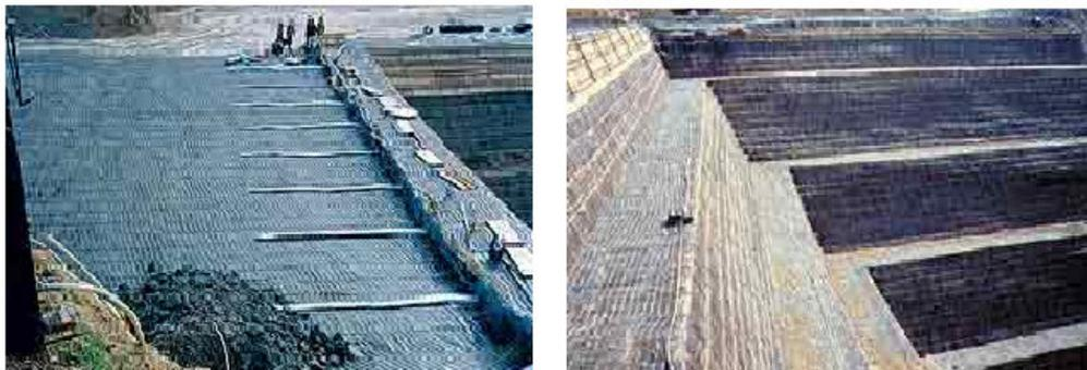
Figura 2.10 - Aterro reforçado de 35m de altura na cidade de Taichung, Taiwan.
