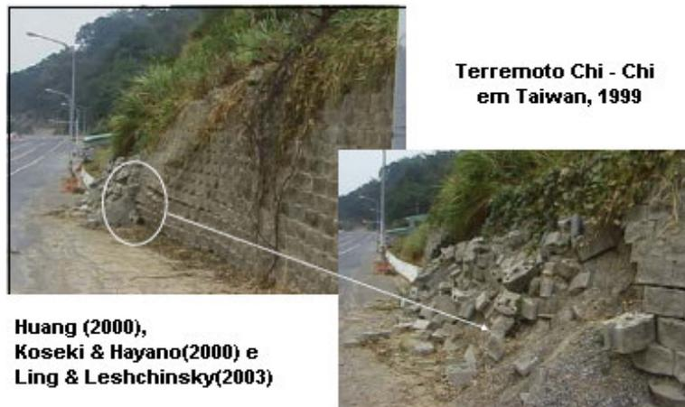
Figura 2.15 - Ruptura do paramento de blocos de concreto do muro reforçado com geossintéticos, após o terremoto Chi – Chi, de magnitude 7.3, em Tai-Chung (Taiwan).
