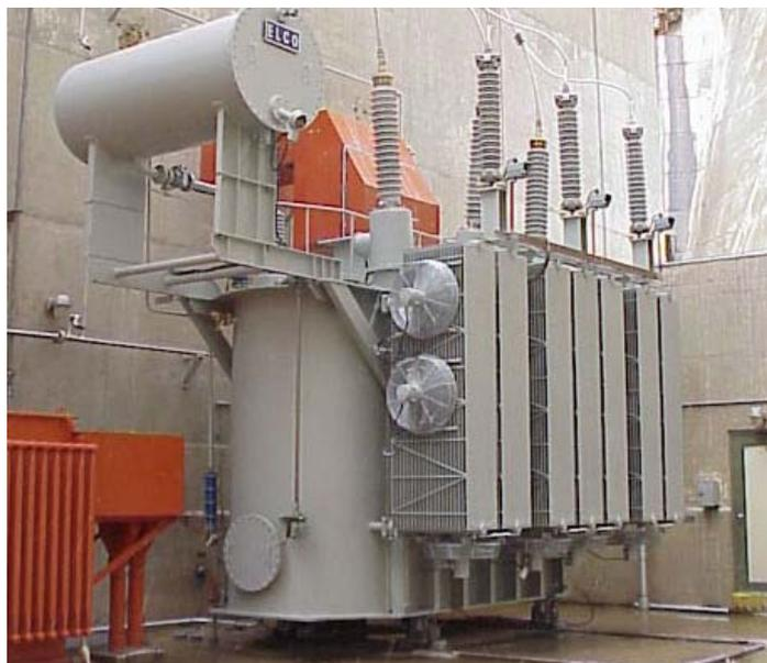
Figura 2 – Transformador de potência trifásico
