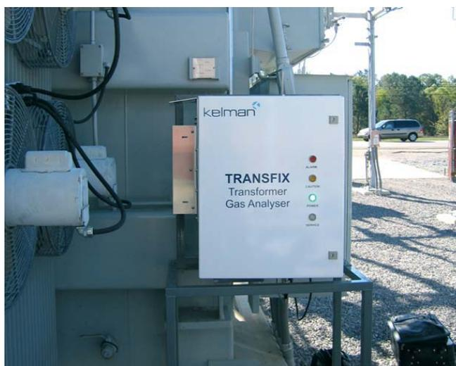
Figura 17 – Utilização do equipamento TRANSFIX de monitoramento on-line acoplado ao transformador de potência
