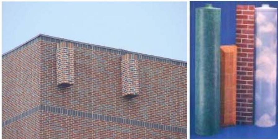
Figura 26: Detalhe de radome em fachada de prédio, em Los Angeles –US, e outras pinturas para o radome. (<http://www.kramerfirm.com/cells/index.php>)
