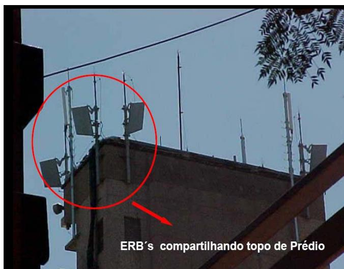
Figura 19: Foto de ERB montada no topo de prédio
