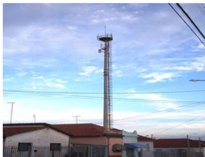
Figura 18: Foto de uma ERB montada em torre.
