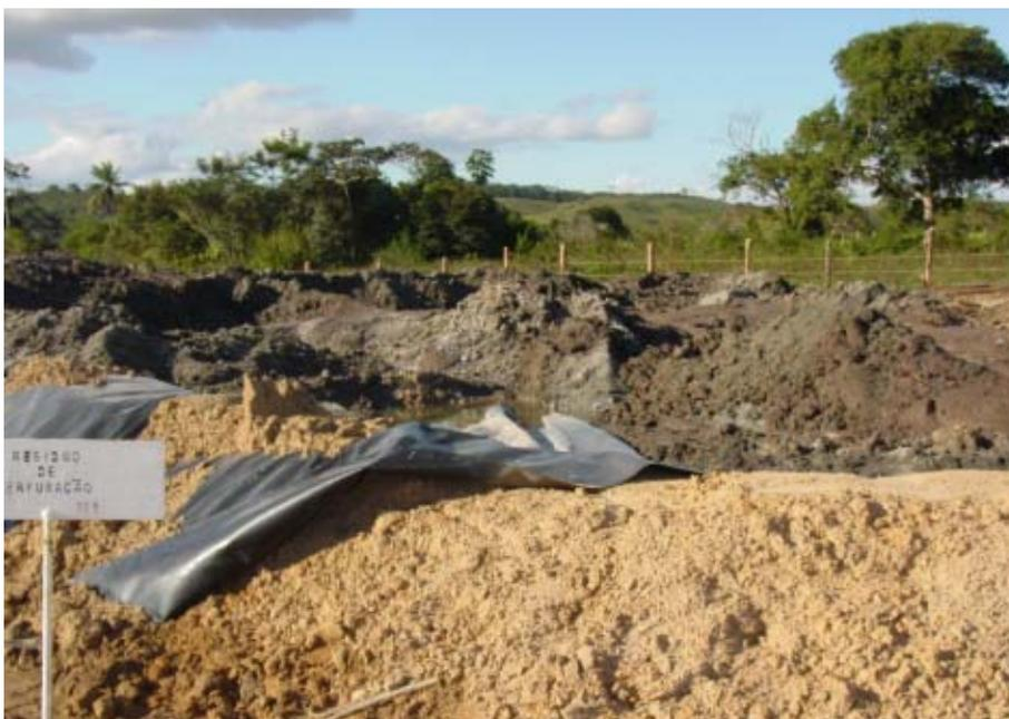
Figura 3-1 – Dique de disposição do cascalho de perfuração do poço FGA 2.
