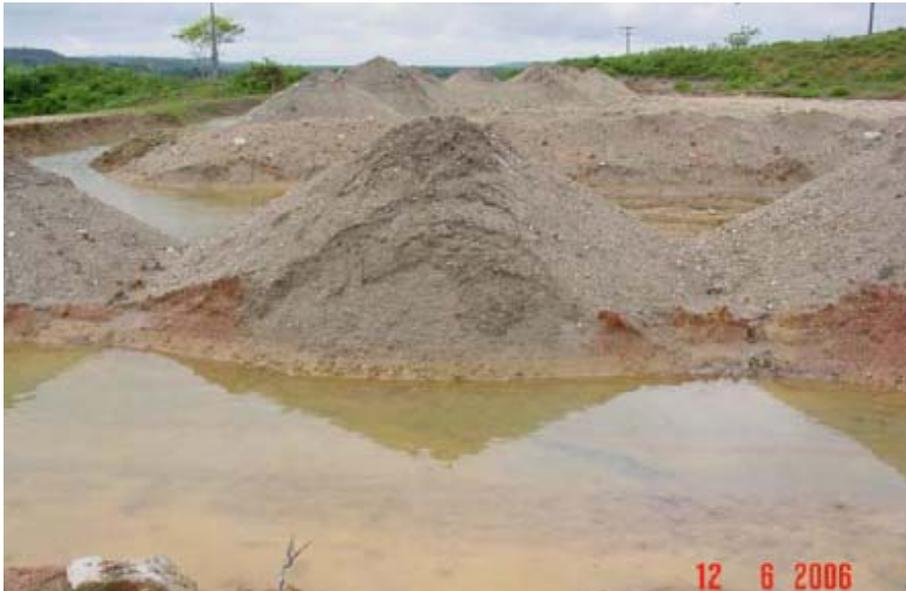
Figura 3-5 - Dique de armazenamento de cascalho de perfuração no Campo de Carmópolis - SE.
