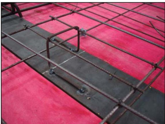
(a) Armadura no espaçador
