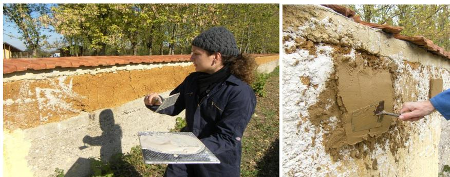
Figura 3.9: A) Lançamento do material de referência (cal + areia); B) Regularização da superfície do traço TA 12% em peso de argila.
