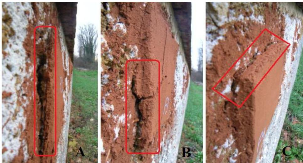
Figura 4.5: Revestimentos descolaram do substrato, mas não tombaram – A) Traço F1 (17,5% de argila); B) Traço F3 (9% de argila); C) Traço F4 (6% de argila).
