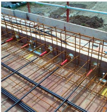
**Figura 2.7 – Sistema não aderente antes do lançamento do concreto. *The concrete Centre*. [3].**
