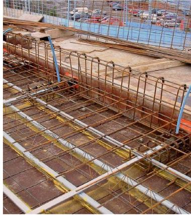
Figura 2.6 – Sistema aderente antes do lançamento do concreto. *The concrete Centre*. [3].
