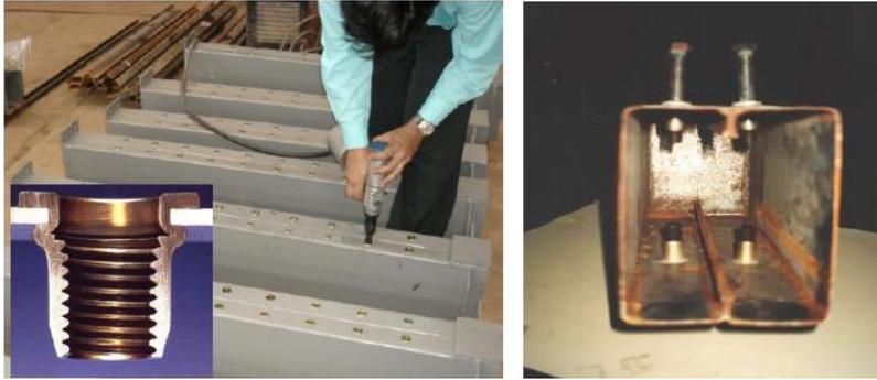
Figura 2.18 – Rebite com rosca interna e parafuso sextavado oliveira (2001).
