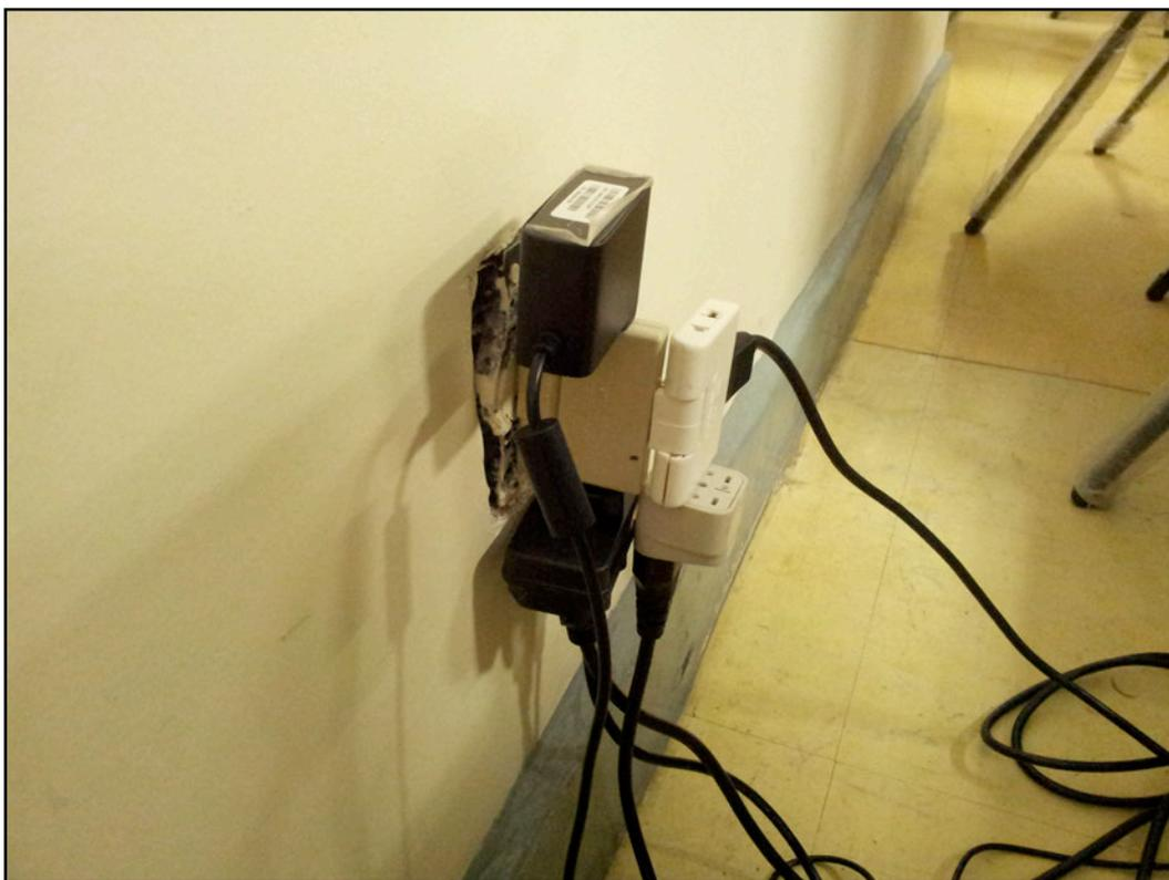
Figura 12: Adaptação improvisada pelos alunos para contornar a falta de tomadas para seus equipamentos eletrônicos.
