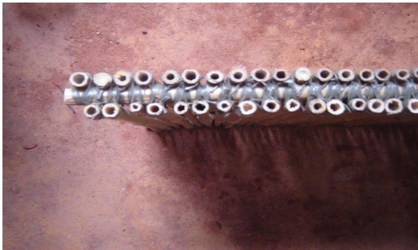
Figura 24: Vista de topo da lâmina para o *brise*, composta por varas finas de bambu amarradas simultaneamente em duas camadas. Percebe-se o vazamento de luz entre as varas. Observar a complexidade da trama de fitilhos.
