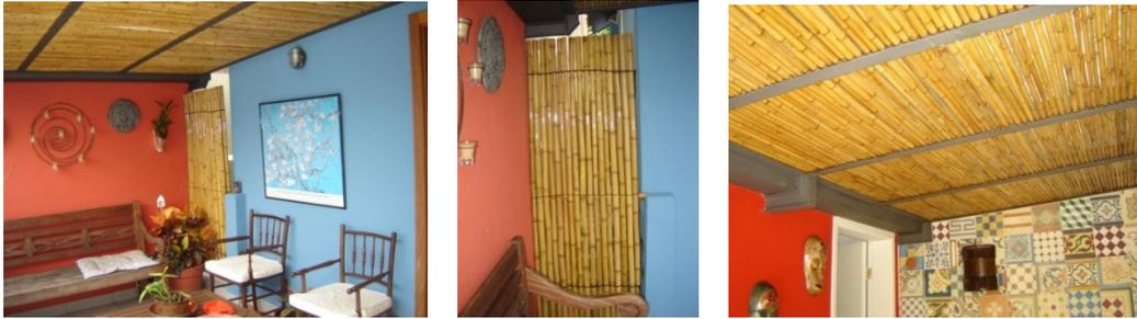
Figura 75: Proteção solar de bambus<sup>21</sup> pintados com resina poliuretânica vegetal, amarrados em esteiras, encaixados e colados com a própria resina à estrutura metálica, sob vidros laminados. Na figura do centro, uma paliçada de proteção visual e permeável ao vento, com o mesmo tratamento do bambu e fixada por amarração.
