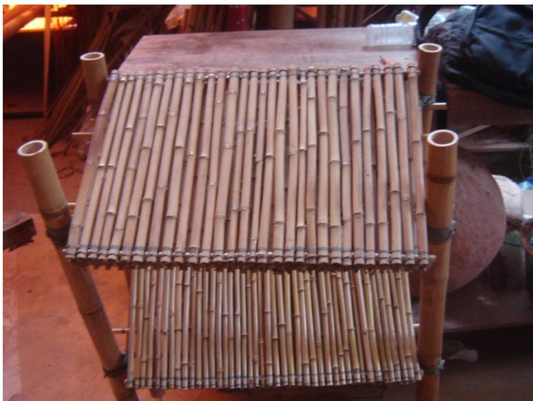
Figura 25: Pré-montagem do *brise* no LILD, ainda sem a aplicação de resina vegetal na estrutura e a colocação das proteções das cabeças em garrafas PET deformadas a fogo. A lâmina composta de fitas de bambu é a de cima.
