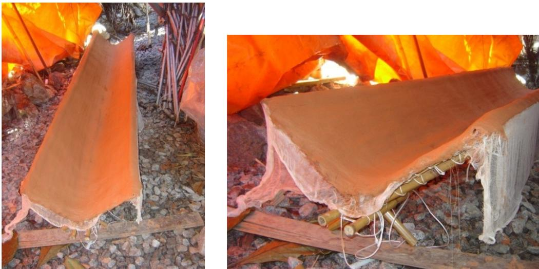
Figura 45: Telha apoiada no piso de brita do LILD. As longarinas avançam para além das extremidades, para facilitar o manuseio, como uma padiola. As sobras laterais da gaze são intencionais, para virar sobre a face inferior, de modo que a emenda da gaze não ocorra nas bordas da telha.
