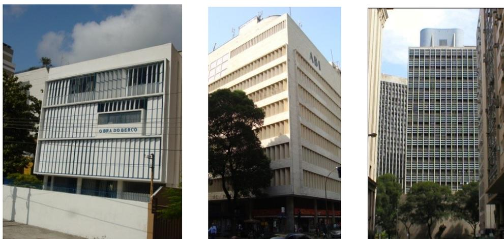
Figura 21: *Brise* vertical de chapas de fibrocimento em caixilho de ferro na fachada oeste da Obra do Berço; *brise* vertical em placas de concreto nas fachadas norte e oeste da ABI; e *brise* horizontal em chapas de fibrocimento em caixilho de ferro na fachada norte do MEC. Todos na Cidade do Rio de Janeiro.
