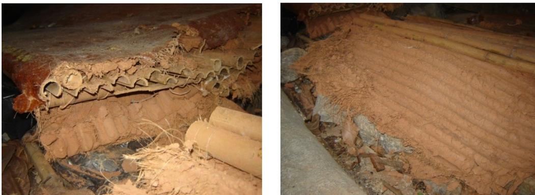
Figura 50: Vista de topo do corte com serrote de uma aba da telha, vindo a manta inferior descolada e embeijada. À direita, a manta arrancada, mostrando as costelas moldadas nos costados das meias-canas do bambu, que reforçam a aderência.
