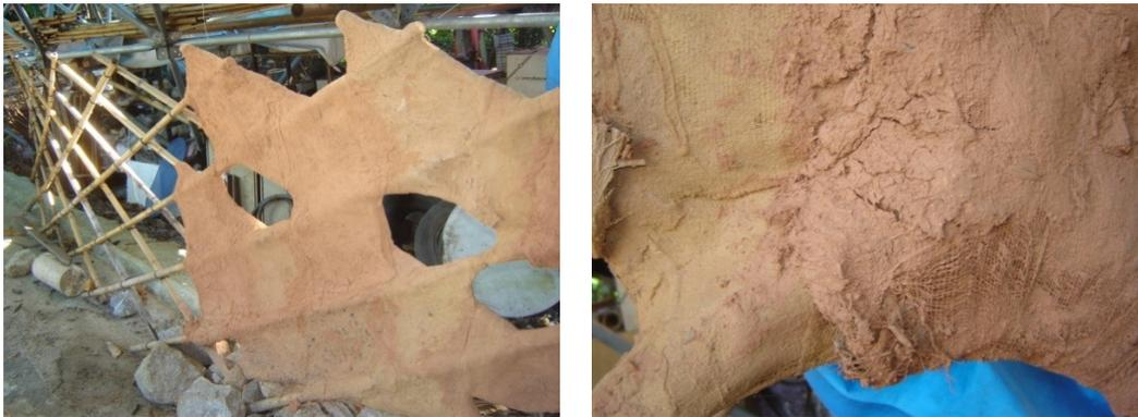
Figura 41: As mantas foram colocadas pela face externa da estrutura pantográfica e viradas por sobre a estrutura de modo a recobri-la inteiramente. No detalhe, manta composta de trama de juta e barro misturado com resina de PVA diluída.
