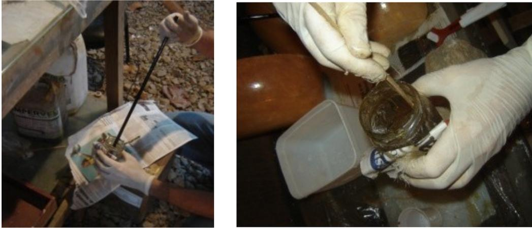
Figura 69: Retirada de resina monocomponente da lata, com pipeta, e preparação da mescla de resina com areia, barro e gesso, com o traço de 1:3:3.
