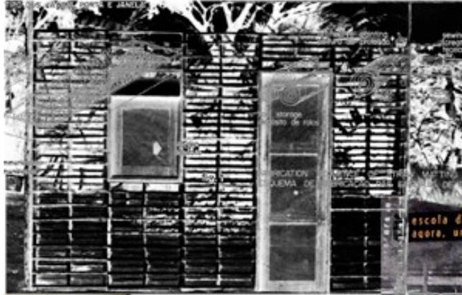
Figura 34: Painéis pré-fabricados com trama ortogonal para taipa, em Cajueiro Seco, PE.
