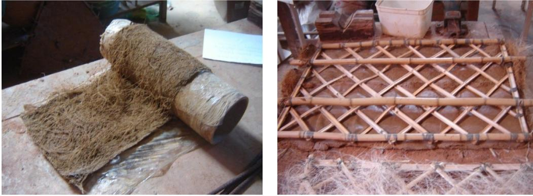
Figura 28: Manta de fibrobarro acondicionada em rolo, protegida por filme plástico. Observar a grande quantidade de fibras de sisal incorporadas ao barro. Na outra imagem, as mantas cortadas já aparecem emendadas, sob a estrutura de bambu. Em primeiro plano, a outra estrutura recoberta com sisal desfiado.
