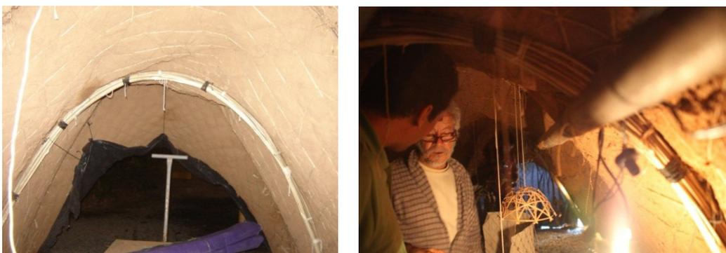
Figura 54: Arco de quatro fitas à esquerda e de seis fitas à direita, com o espaço em uso.
