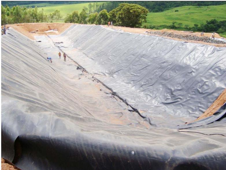
**Figura 1.3 - Membrana de proteção de aterro sanitário**
