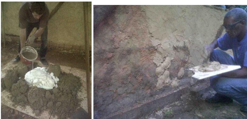
Figura 47: Preparando a massa do reboco e observando o gesto técnico de Messias na aplicação com a colher de pedreiro, Escola Parque, 2013.
