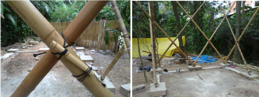
Figura 18: detalhe da conexão de torniquete e da pré-montagem da estrutura treliçada de mossô, Escola Parque, 2012.
