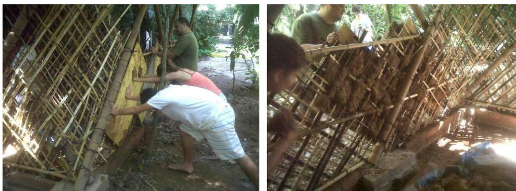
Figura 42: Técnica do sopapo realizado no mutirão, vista interna e externa.
