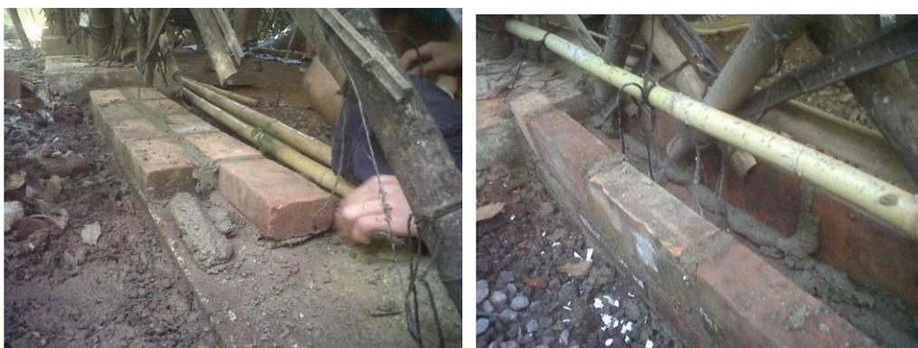
Figura 39: Alunos aprendendo a executar a função de colocação do tijolo na cinta, ao lado uma seção do perímetro da sala terminada, Escola Parque, 2013.
