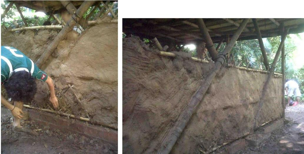
Figura 43: Alisando a parede frontal embarrada, ao lado o aspecto após o alisamento, Escola Parque, 2013.
