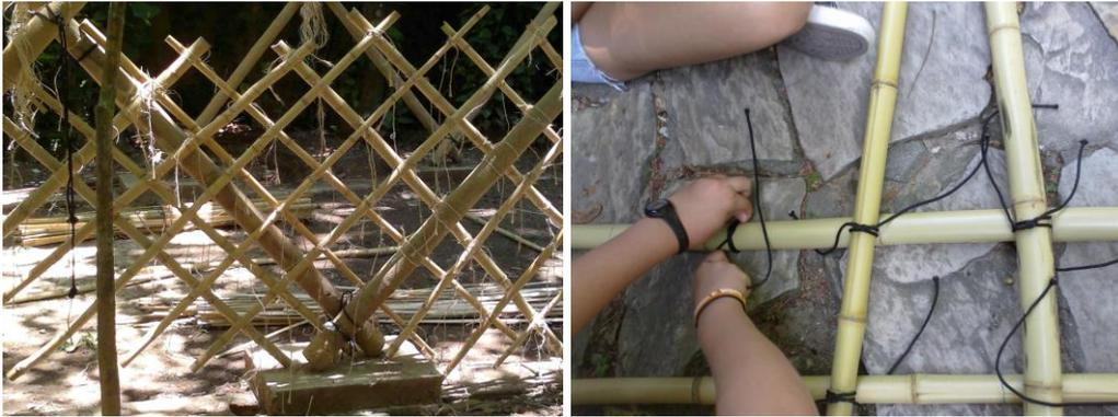
Figura 24: instalação de uma treliça pronta e detalhe da amarração, Escola Parque, 2012.
