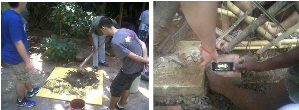
Figura 38: Alunos aprendendo com Messias a fazer o cimento para assentar os tijolos na base da fundação (cinta). No detalhe, o uso do nível digital no *smartphone*, Escola Parque, 2013.
