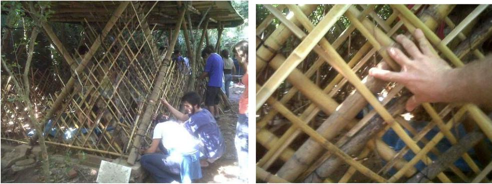
Figura 35: Colocação de fitas de bambu na parede que recebe o sopapo, Escola Parque, 2013.
