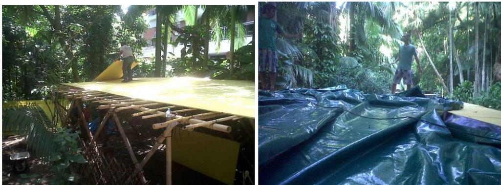
Figura 32: Colocação das placas OSB e revestimento com lona PVC, Escola Parque, 2013.
