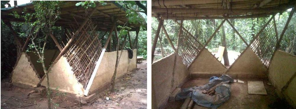
Figura 50: Aspecto da sala com a camada do reboco terminada, Escola Parque, 2013.
