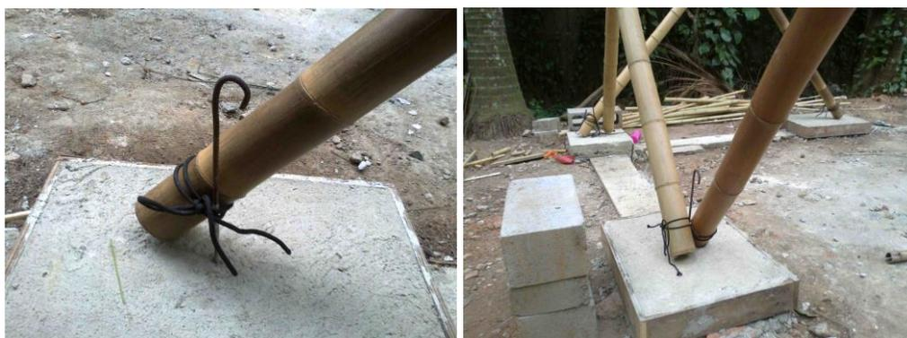
Figura 17: detalhe da fixação amarrada dos colmos de bambu mossô na sapata componente da fundação rasa, Escola parque, 2012.
