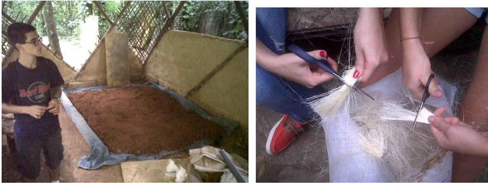
Figura 40: A terra peneirada e pronta para receber água e fibras de sisal para ser pisoteada, ao lado o sisal sendo cortado em tamanhos variados, Escola Parque, 2013.
