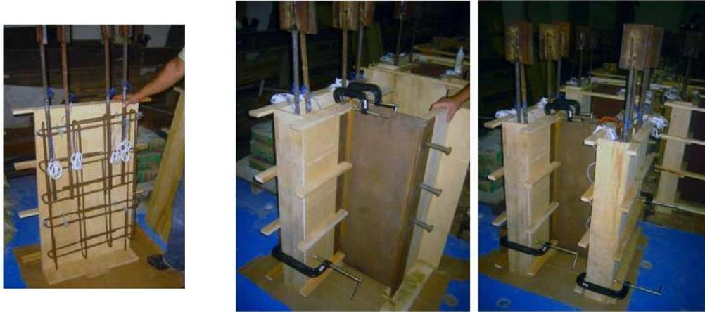
**Figura 3.43 – Montagem das formas de madeira (Ramires, 2010).**
