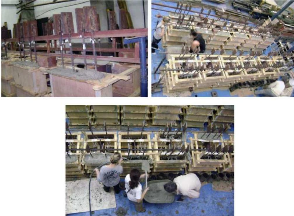
Figura 3.36 – Concretagem dos ensaios principais (Ramires, 2010).
