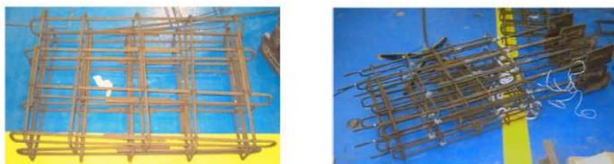
**Figura 3.28 – Montagem das armaduras (Ramires, 2010).**
