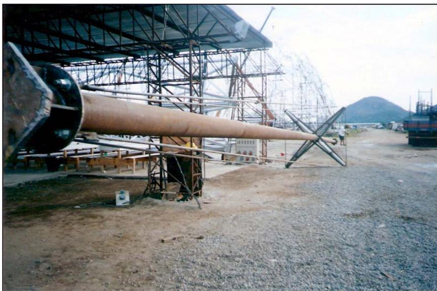
Figura 1.3 Coluna de aço estaiada utilizada como suporte temporário durante a construção do palco mundo no evento Rock in Rio III.
