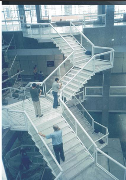
Figura 1.2 – Escada construída com perfil “C”.
