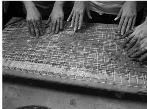
Figs. 35 e 36. Fibra sendo adicionada ao barro, e tela com barbantes sendo aplicada sobre o barro.
