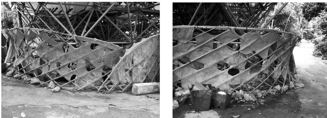
Figs. 21 e 22. Vistas do muro de fibrobarro armado
