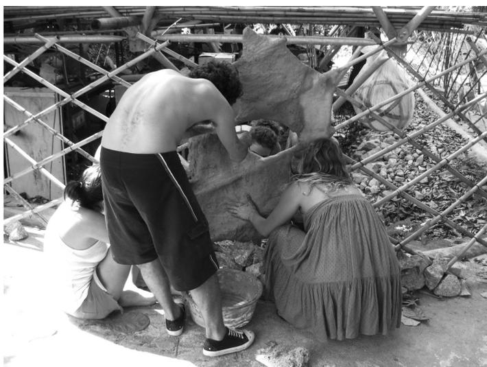
Fig. 20. Grupo de alunos trabalhando coletivamente na aplicação do fibro barro na estrutura de bambu
