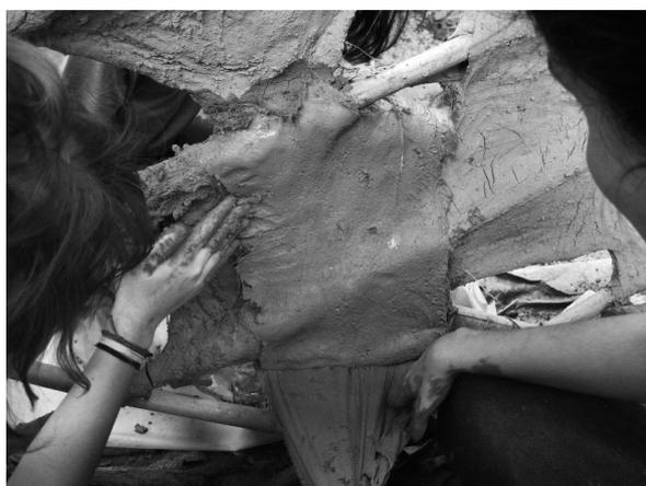
Fig. 43. Plástico que estruturou o barro em sua colocação no muro sendo retirado.
