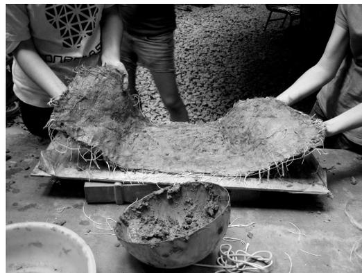
Figs. 37 e 38. Tela sendo entranhada no barro e, após o barbante ser separado da moldura, sendo retirada para ser levada para o muro.
