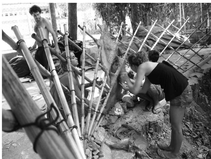
Fig. 15. Estrutura pantográfica de bambu onde o barro é aplicado
