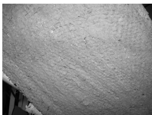
Figs. 44 e 45. Tecido sintético que imita a juta e faixa deste tecido barreado no muro.
