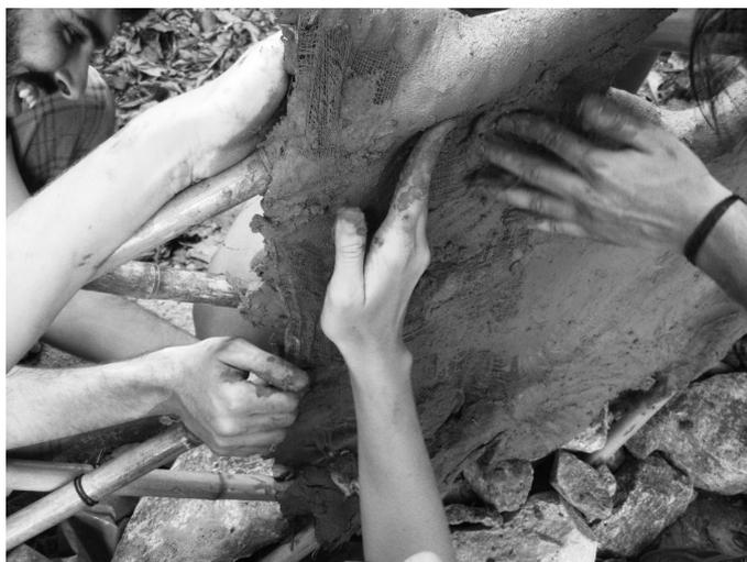
Fig. 19. Faixa de barro sendo aplicada na estrutura de bambu
