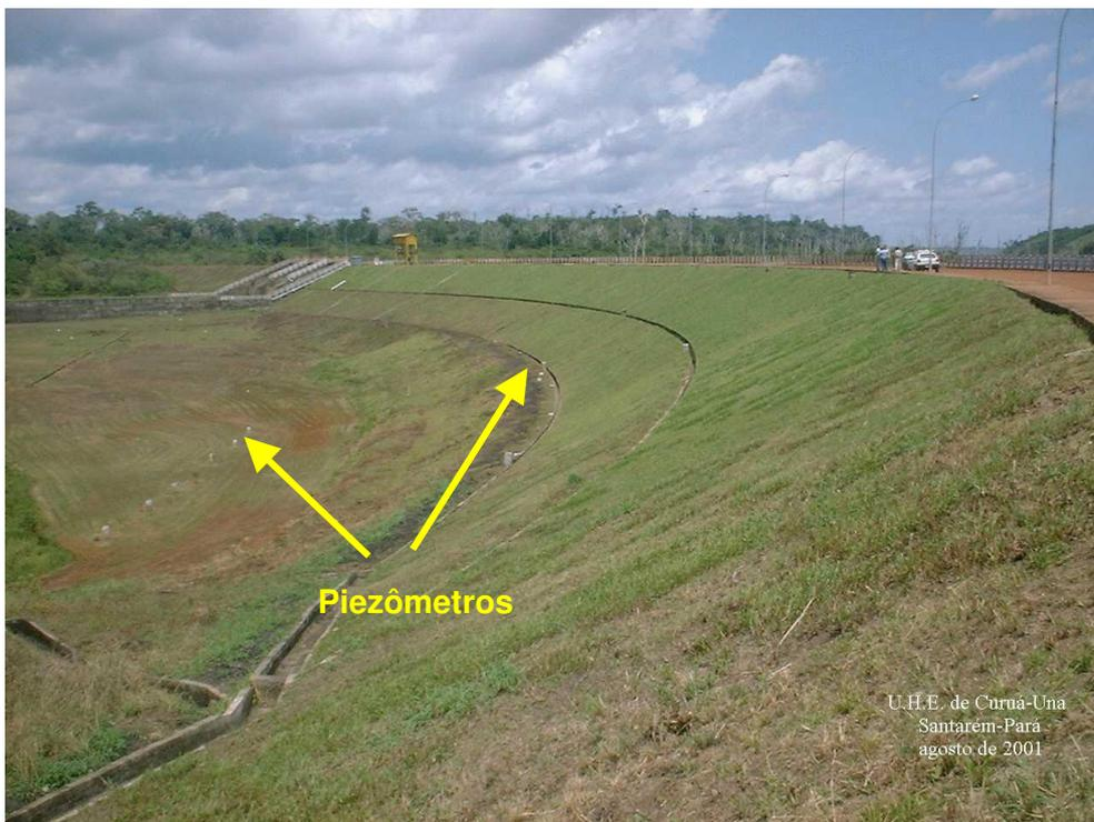
Figura 51 - Vista do talude de jusante e localização dos piezômetros
