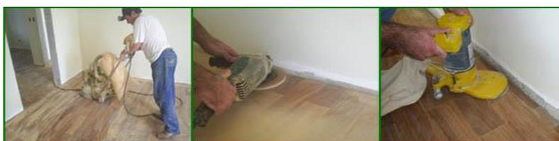
**Figura 138 – Máquinas lixadeiras grandes e portáteis para dar acabamento ao piso de taco (MADIPÊ)**
