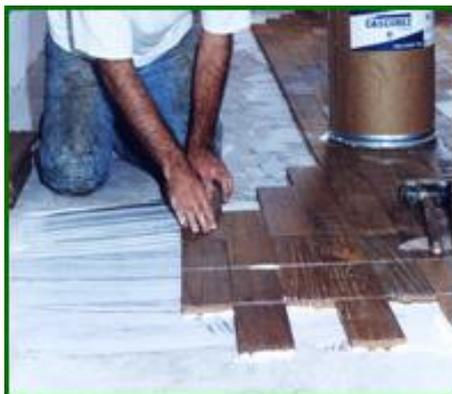
**Figura 137 – Etapas para a instalação do piso de madeira – Piso de taco (MADIPÊ).**
