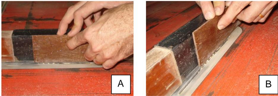
**Figura 148 – Detalhe da feitura do encaixe macho e fêmea no taco**
