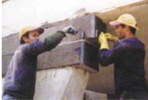
Figura 2.11 - Aplicação do rolo tira bolhas sobre o tecido já aderido no substrato pela aplicação do epóxi estruturante. Foram utilizadas cerca de seis camadas, em média, nos diversos níveis da altura dos pilares.
