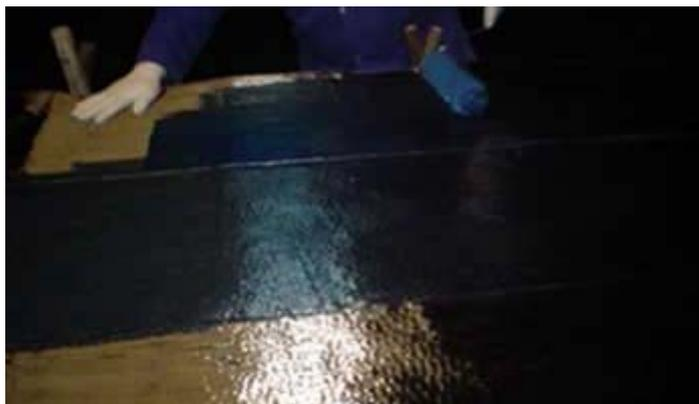
Figura 2.21 - Imprimação do tecido de fibra de carbono MBrace CF 130 com resina MBrace Saturant sobre bancada, instantes antes da instalação.
