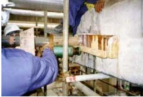
Figura 2.17 – Recolocação da viga na posição original.
