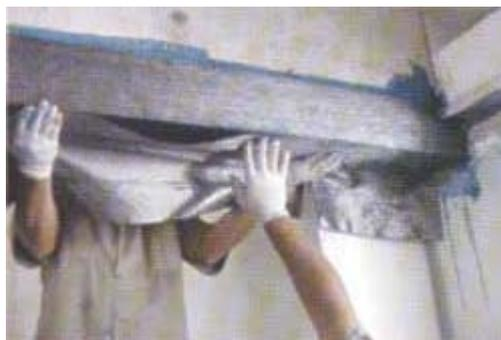
Figura 2.28 - A 2ª camada sendo aplicada na região inferior da viga V11a.
