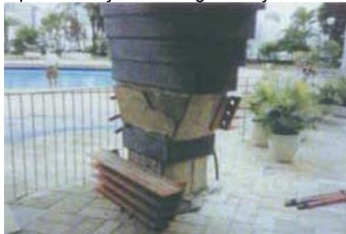
Figura 2.14 - A remoção do reforço da estrutura metálica em andamento.
