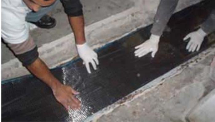
Figura 2.22 - Colocação do tecido de fibra de carbono sobre substrato já regularizado com MBrace Putty.
