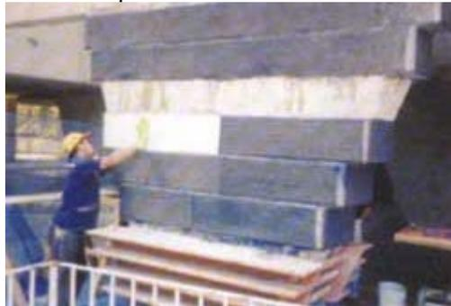
Figura 2.12 - Os diversos níveis de aplicação do reforço com fibra de carbono.
