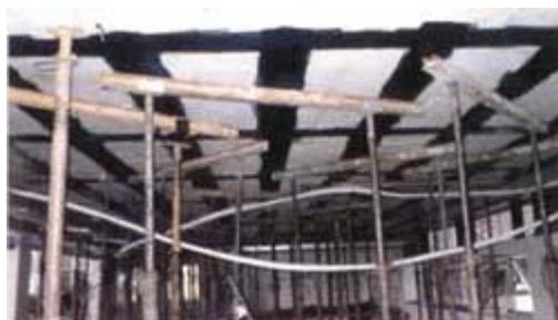
Figura 2.25 - A laje após o reforço com fibra de carbono.
