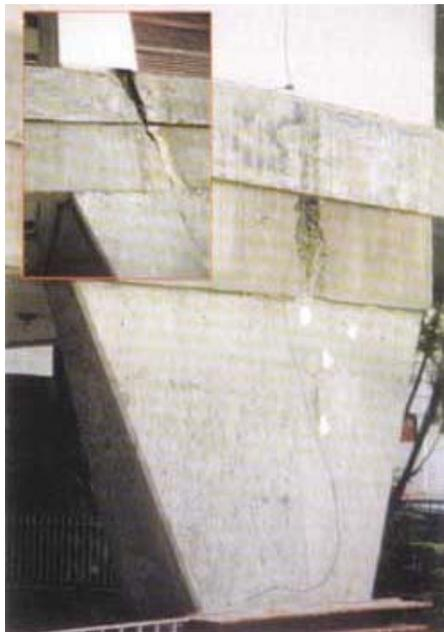
Figura 2.9 - A situação dos pilares com trincas e fissuras verticais é evidenciada neste exemplo.
