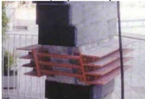
Figura 2.13 - Situação típica de um pilar já reforçado com fibra de carbono, esperando o tempo de cura de 7 dias para remoção do antigo reforço metálico existente.
