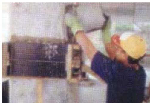
Figura 2.10 - Modificação da seção variável dos pilares, com utilização de fôrma e micro-concreto.
