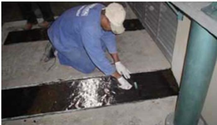
Figura 2.23 - Aplicação do rolo metálico frisado para remoção de possíveis bolhas de ar.
