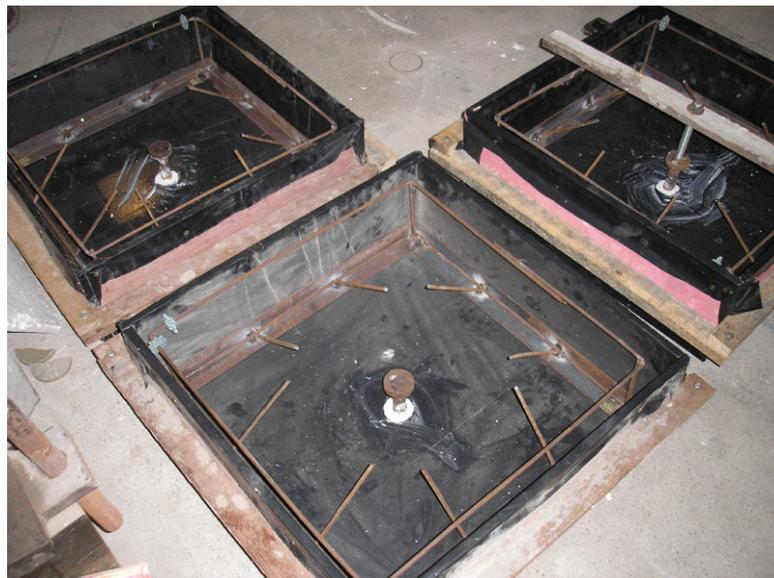
Figura 3.9 – Blocos antes da concretagem.
