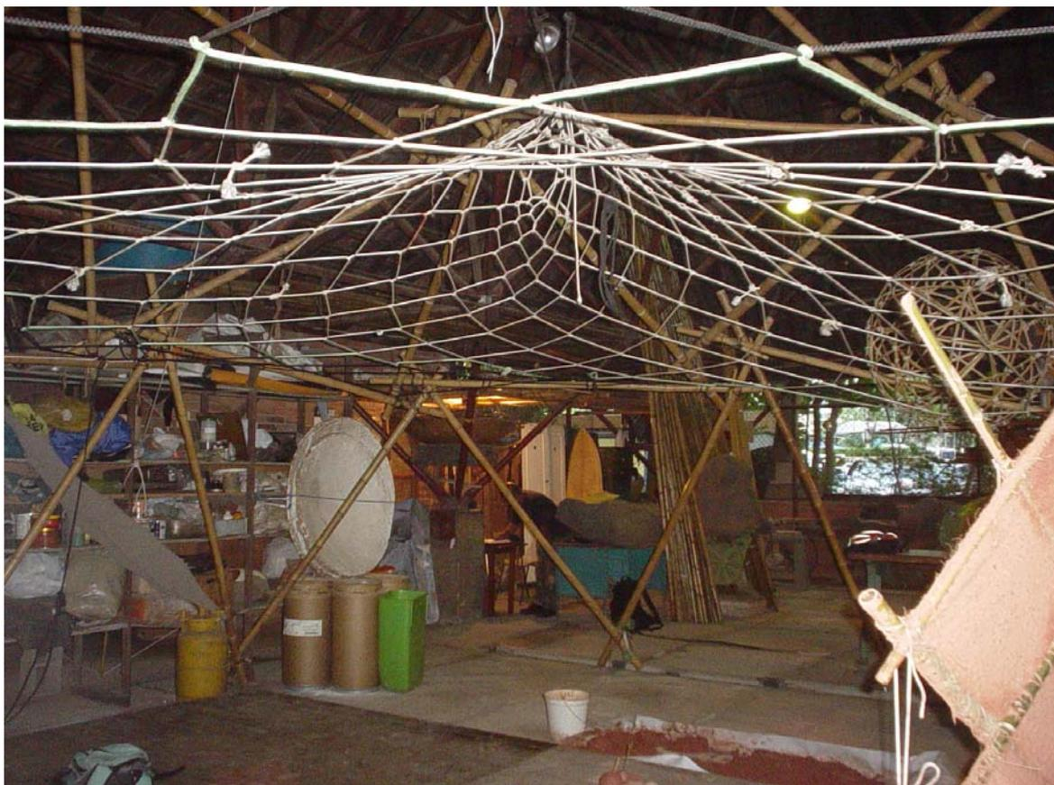
Figura 88 – Rede para cobertura de domus geodésico de bambu *tensegrety* construída no LILD.
